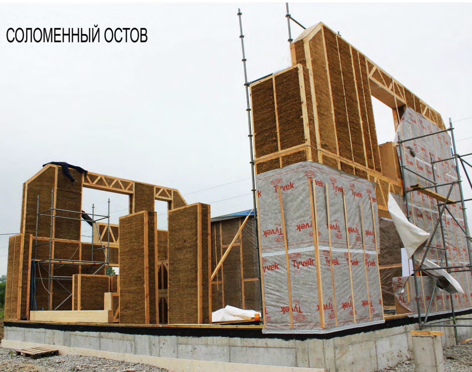
КРОВЛЯ ОПИРАЕТСЯ НА РАМЫ. РАМЫ С БАЛКОНАМИ ПРИДАЮТ ДОМУ ДОПОЛНИТЕЛЬНУЮ ЖЕСТКОСТЬ
