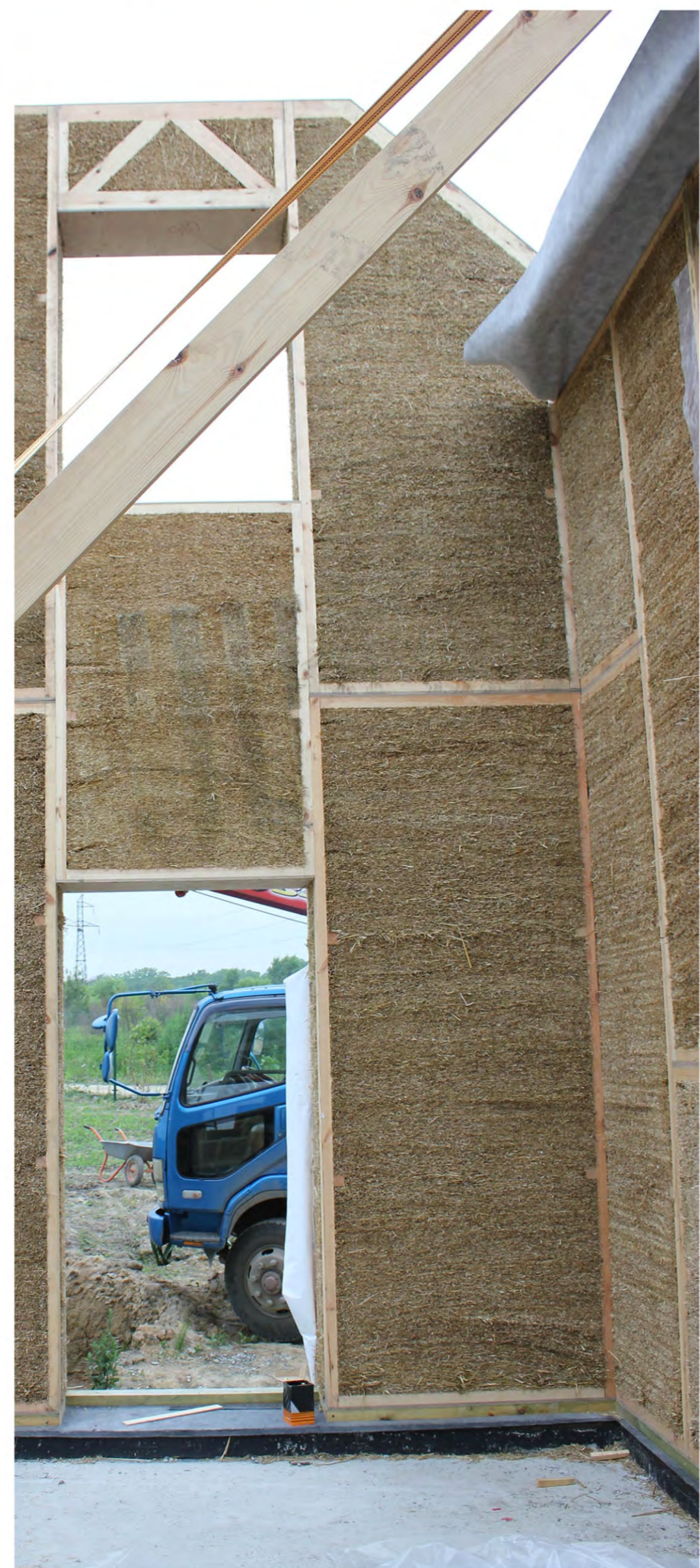
КРОВЛЯ ОПИРАЕТСЯ НА РАМЫ. РАМЫ С БАЛКОНАМИ ПРИДАЮТ ДОМУ ДОПОЛНИТЕЛЬНУЮ ЖЕСТКОСТЬ
