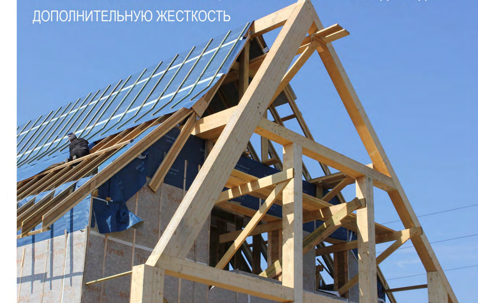
КРОВЛЯ ОПИРАЕТСЯ НА РАМЫ. РАМЫ С БАЛКОНАМИ ПРИДАЮТ ДОМУ ДОПОЛНИТЕЛЬНУЮ ЖЕСТКОСТЬ
