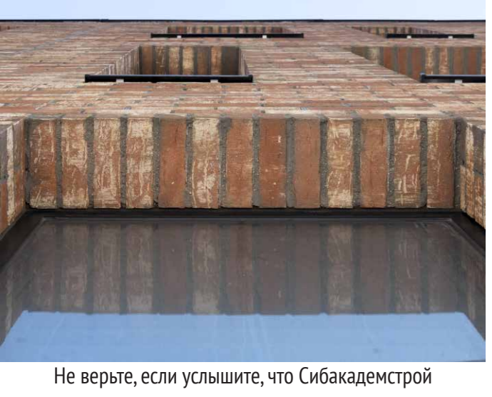
Не верьте, если услышите, что Сибкадстрой делает кирпичные перемычки первыми в городе
