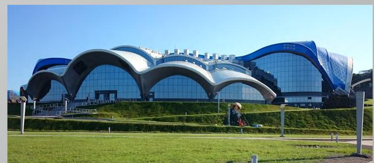
Площадь стеклянной сферы  $S = 400$  кв. м.,  $R = 14$  м.. Сфера состоит из стальных треугольных элементов с заполнением стеклопакетом, 100 из которых - нестандартные.
