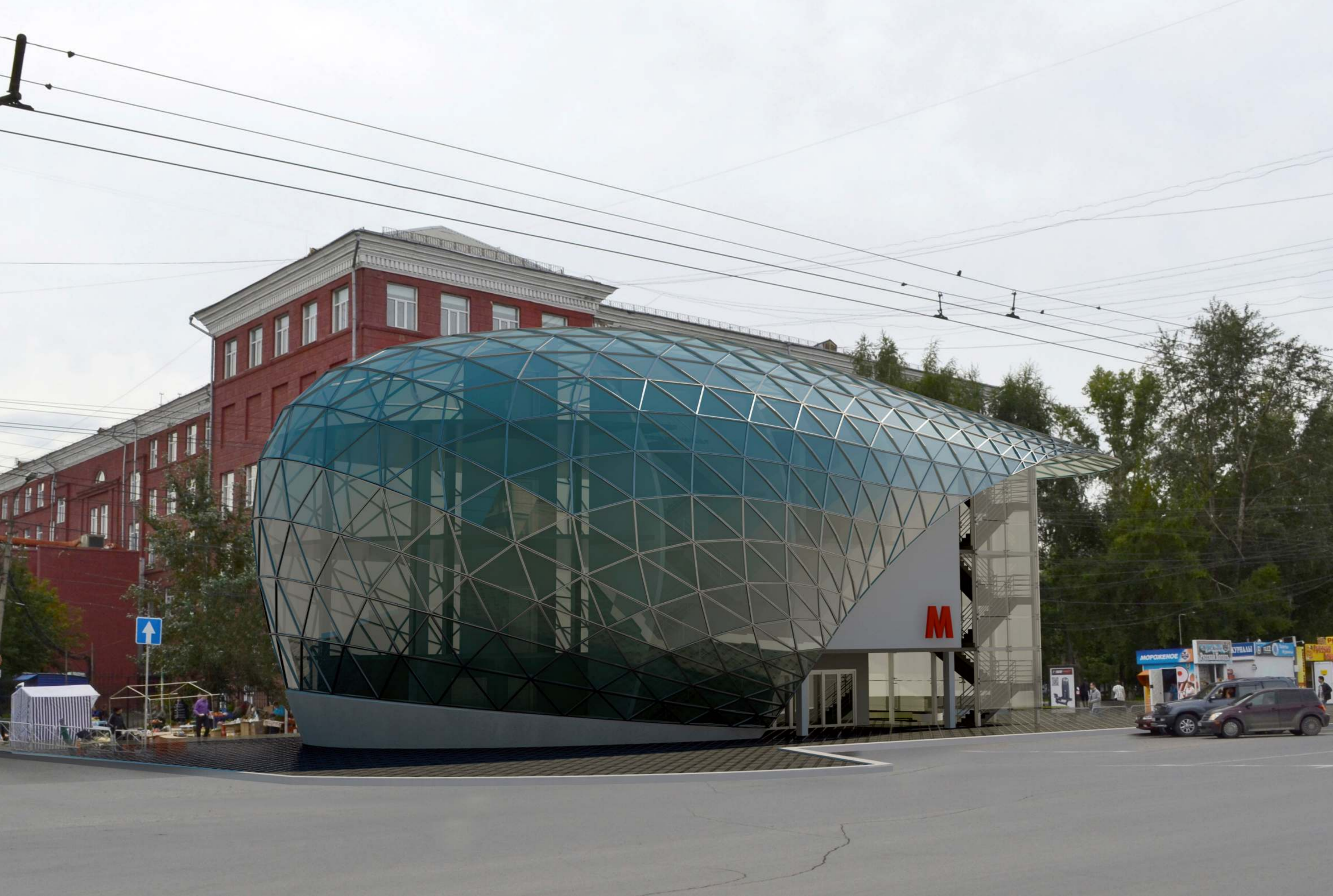
РЕКОНСТРУКЦИЯ ВХОДА №4 В СТАНЦИЮ МЕТРО «СТУДЕНЧЕСКАЯ» В НОВОСИБИРСКЕ
