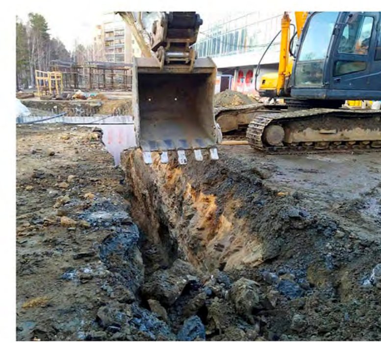
Прокладка коммуникаций фонтана
