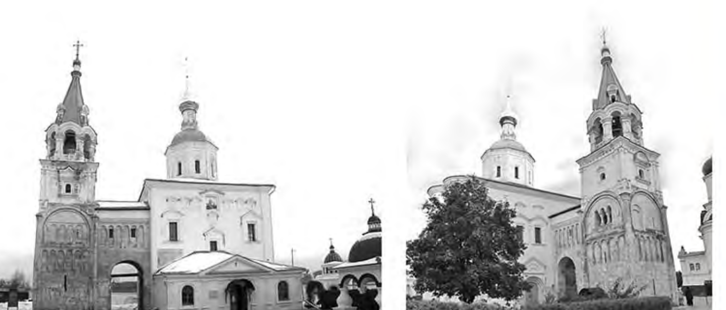
Общий вид с южной стороны Вид с северо-восточной стороны
