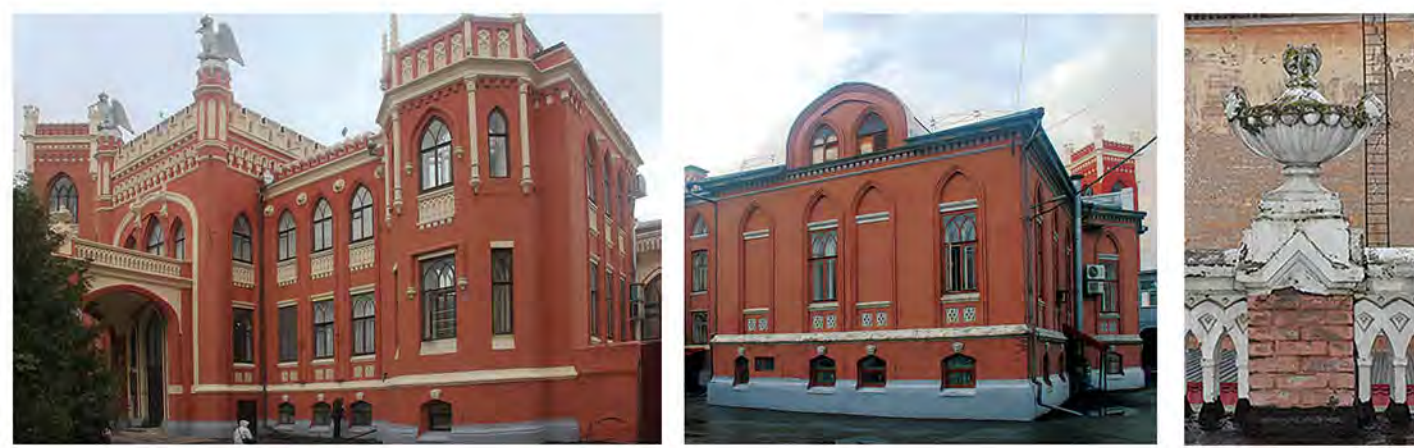
Современное состояние. Западный (главный) фасад
