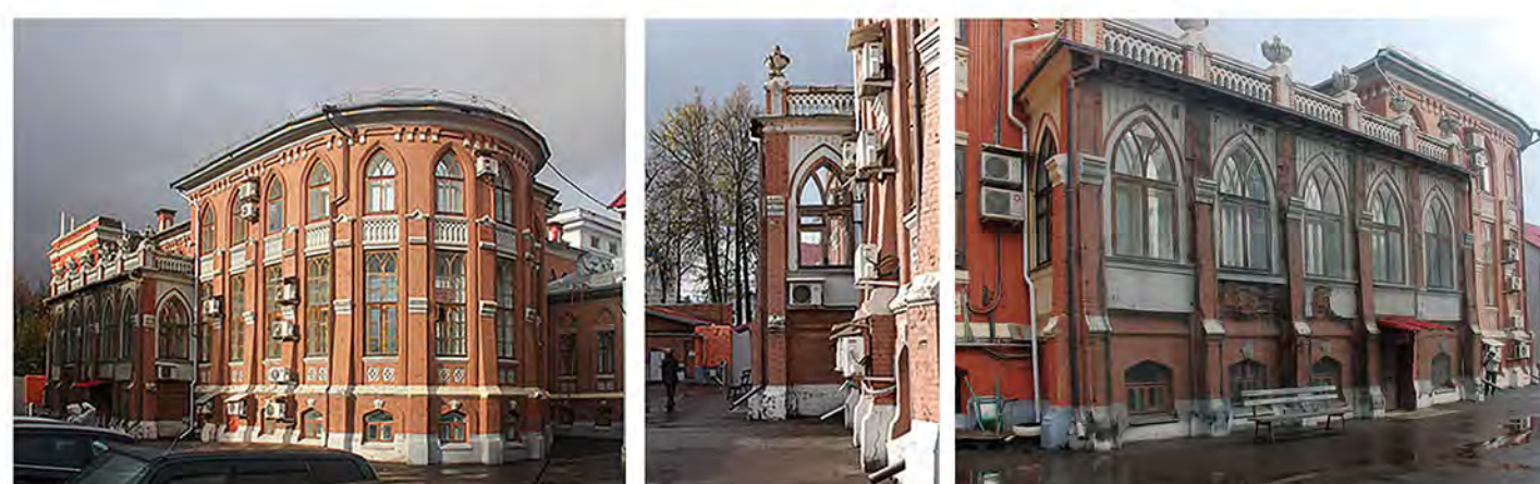
Современное состояние. Южный фасад
